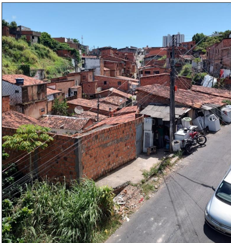
Foto 70: Vista da encosta ao longo da ladeira José C. da Silva, onde se concentram os danos observados na AT-06A. (Fonte: Google Earth).
