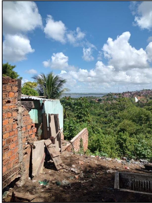
Foto 20: Vista a partir da encosta do tabuleiro na parte noroeste da AT-02.
