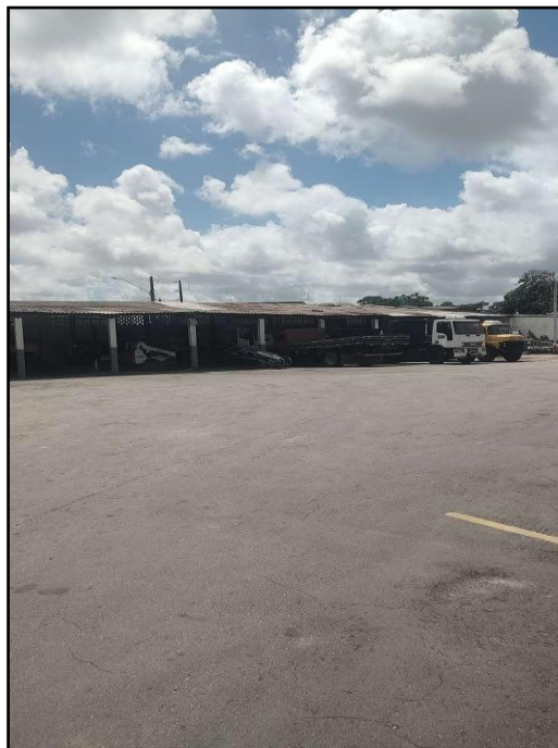
Foto 39: Vista geral do pavimento da garagem da Seminfra. Sem danos evidentes.
