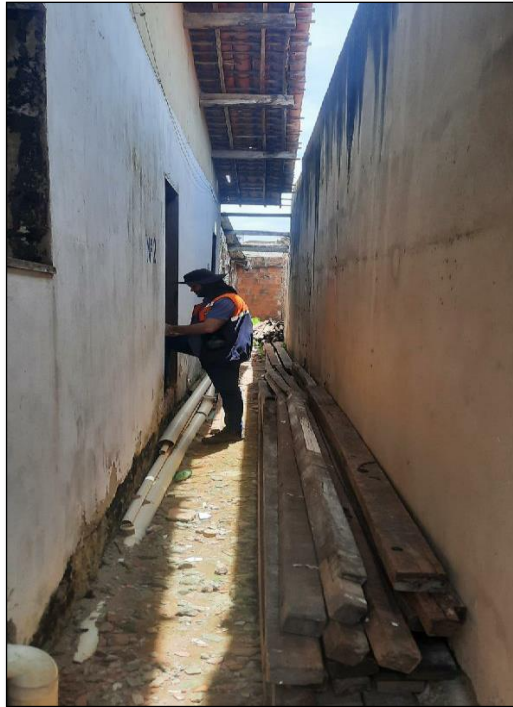
Foto 132: Casas construídas sob aterro irregular de metralha com restos de demolições de imóveis antigos.
