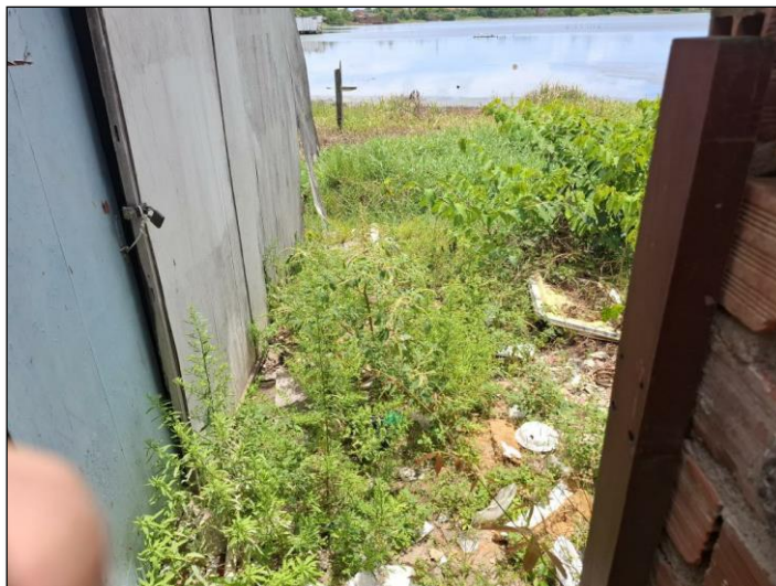
Foto 134: Imóvel construído na margem da laguna em aterros irregulares sobre terreno de argila compressiva.
