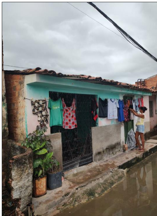
Foto 151: Exemplo de imóvel construído em área alagadiça. Situação comum na AT-06B (NT.GEO-002.24 (RJQDOSSANTOS)).
