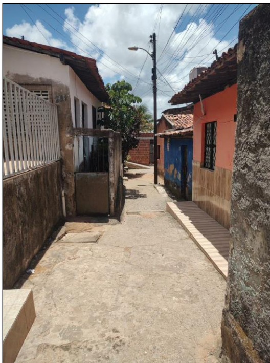
Foto 105: Vista do beco para oeste. Ao caminhar é possível perceber vazios subterrâneos ao longo do beco, evidenciado pelo barulho oco.
