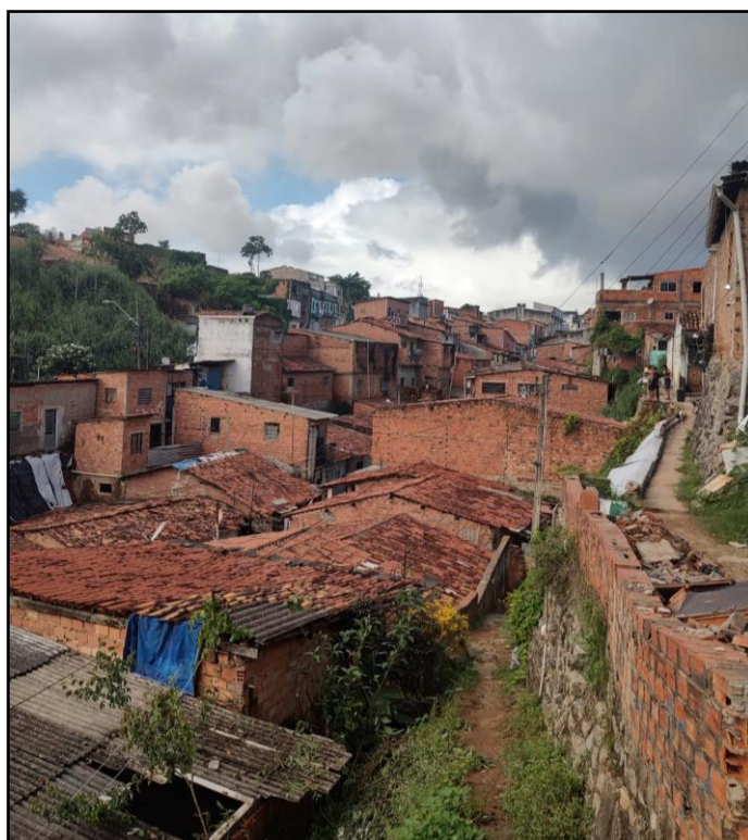
Foto 95: Vista da encosta ao longo da ladeira José C. da Silva, onde se concentram os danos observados na AT-06A. (Fonte: Google Earth).
